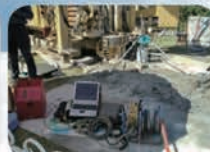
2017년 지진관측장비 설치용 시추공사(기상청)
